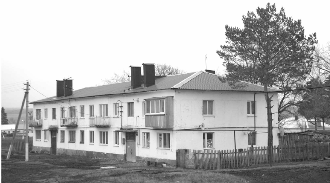
В посёлке Красный Строитель в рамках региональной программы капитального ремонта общего имущества многоквартирных домов проведена реконструкция плоских крыш на скатные 11 из 12 домов
